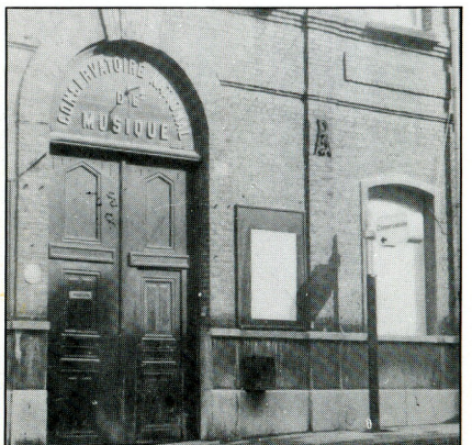
Entrée du conservatoire de musique rue de Soubise
