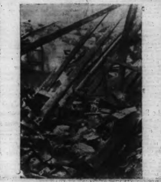
Le hangar écroulé de la rue d'Anras, à Lille On lira plus loin le compte-rendu de cet accident qui a causé la mort d'un homme, au cours d'une partie de bouillon. -- Son partenaire, protégé par la poutre qu'on voit à droite, est resté sans blessure.
