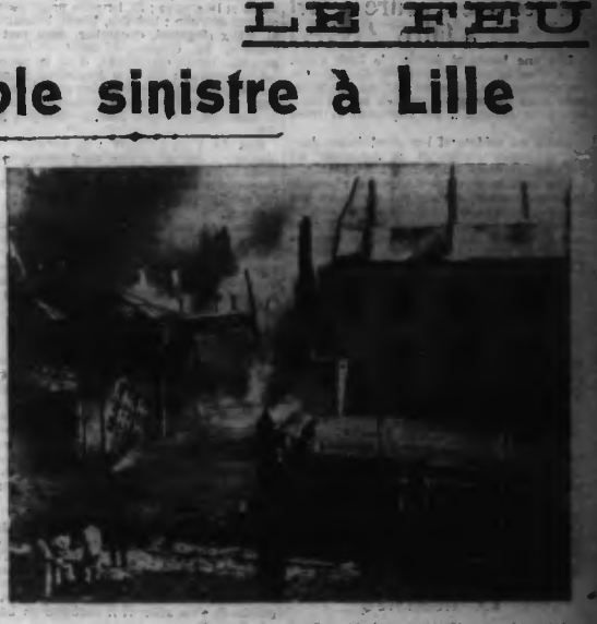
A droite, la maison de M. Desrumeaux, dépositaire de la blanchisserie de Don ; à gauche, les hangars du dépôt d'huiles de M. Derveaux ; ces hangars se sont écroulés dans un fracas.
