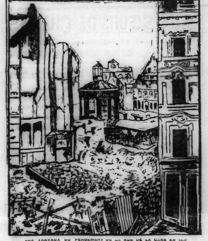
LES TRAVAUX DE PAVEMENT DE LA RUE DE LA GARE EN 1910. Au premier plan, maisons de la place du Théâtre démolies; au second plan, le Marché aux Poissons; au fond, la Gare des Voyageurs
