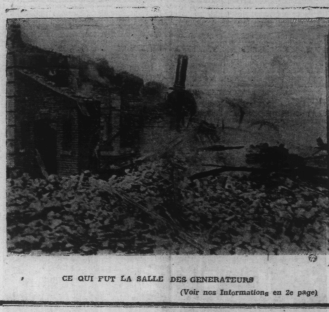
CE QUI FUT LA SALLE DES GENERATEURS (Voir nos Informations en 2e page)
