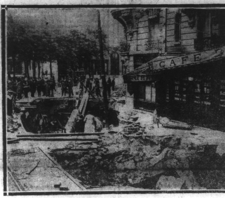
LES EXCAVATIONS DU SOL DANS LA RUE DE LA BOÉTIE À PARIS OU DE NOMBREUSES PERSONNES PERIRENT
