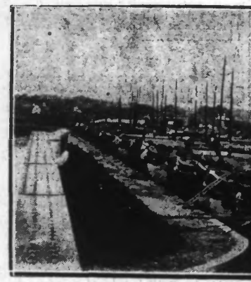
LA GARE D'EAU DE BETHUNE
