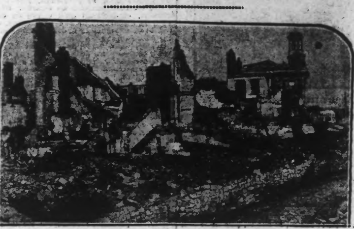
LES RUINES DE LA RUE PASTEUR
