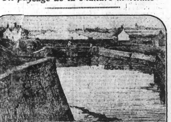
L'ECLUSE DE GRAVELINES
