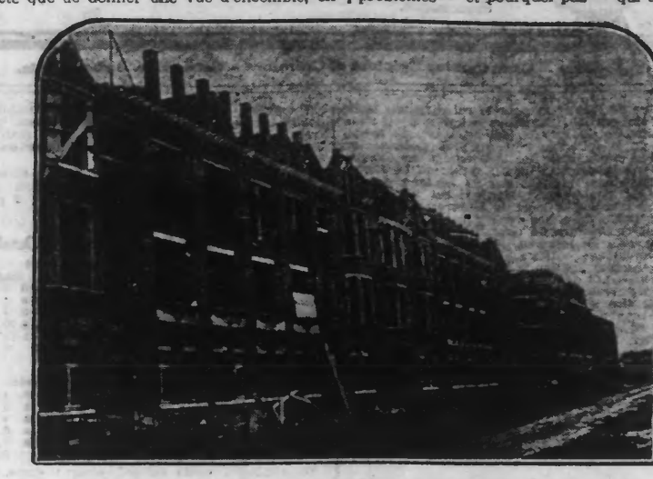
UN GROUPE DE MAISONS OUVRIÈRES EN VOIE D'ACHEVEMENT
