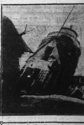
Cette construction bizarre n'est autre que le sommet du phare de Brème, arraché de sa tour au cours d'une récente tempête. La construction était si solide, que la partie projetée vers le terre restée presque indemne malgré la terrible chute.
