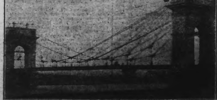
Ce magnifique ouvrage d'art, réplique du pont de Westminster, à Londres, se trouve aux Portes de Paris et relie Vitry à Malo-les-Bains. On en termine actuellement le tablier et il sera livré sous peu à la circulation.
