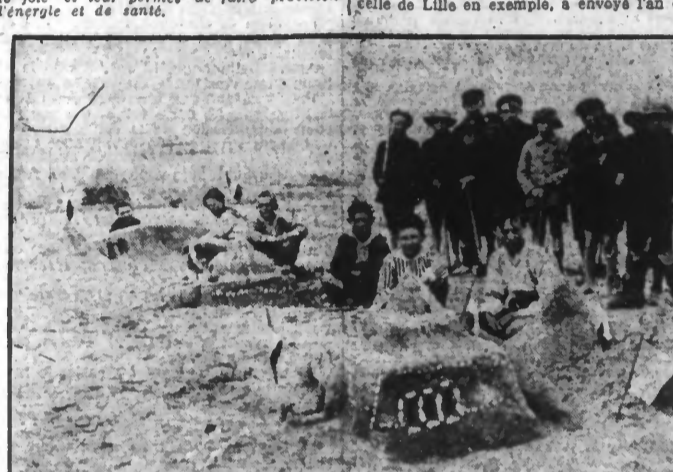
LES TRAVAUX DE SABLE A LA MER
