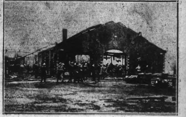
LE BATIMENT C. INCENDIE
