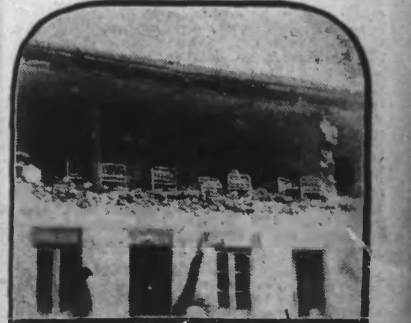
On sait qu'un tremblement de terre a fait d'énormes dégâts et de nombreuses victimes à Corinthe. Voici un des tableaux de désolation que l'on voit dans la ville. C'est celui de l'Hôtel de la Grande-Bretagne, ouvert l'avant veille du séisme, qui avait coûté trois millions de drachmes et que notre photo montre ici complètement détruit. On remarque l'alignement des fils dans les chambres.
