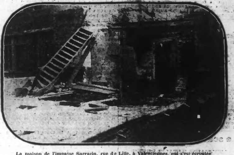
La maison de l'impasse Sarrazin, rue de Lille, à Valenciennes, qui s'est écroulée.
