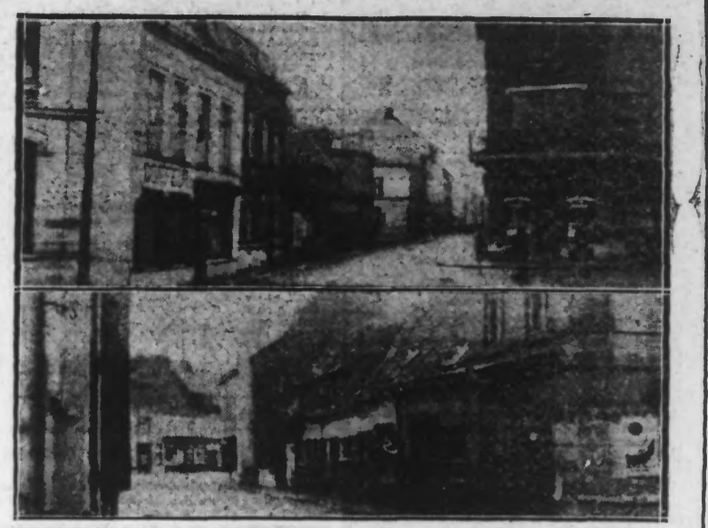
EN HAUT : L'entrée de la nouvelle avenue dherbe. — EN BAS : Le coin du vieux Tourcoing qui disparaîtra le premier sous la pioche des démolisseurs.
