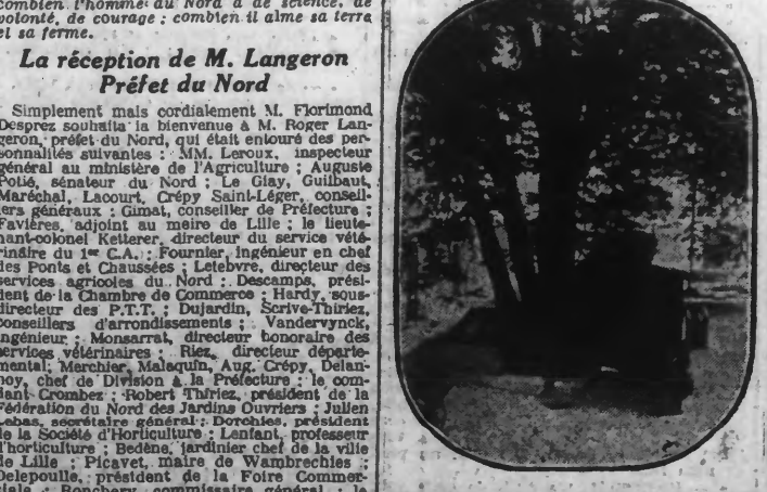
Un propriétaire parisien qui faisait construire à Lille, a voulu respecter un bel arbre centenaire planté dans le terrain. Il en a fait planter la tige d'une tour de ciment armé, de façon à ce que les racines s'écartent de la terrasse supérieure de la construction.
