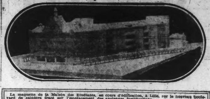
La maquette de la Maison des Etudiants, en cours d'érection, à Lille, sur le nouveau boulevard de ceinture tracé sur l'emplacement des anciennes fortifications.
