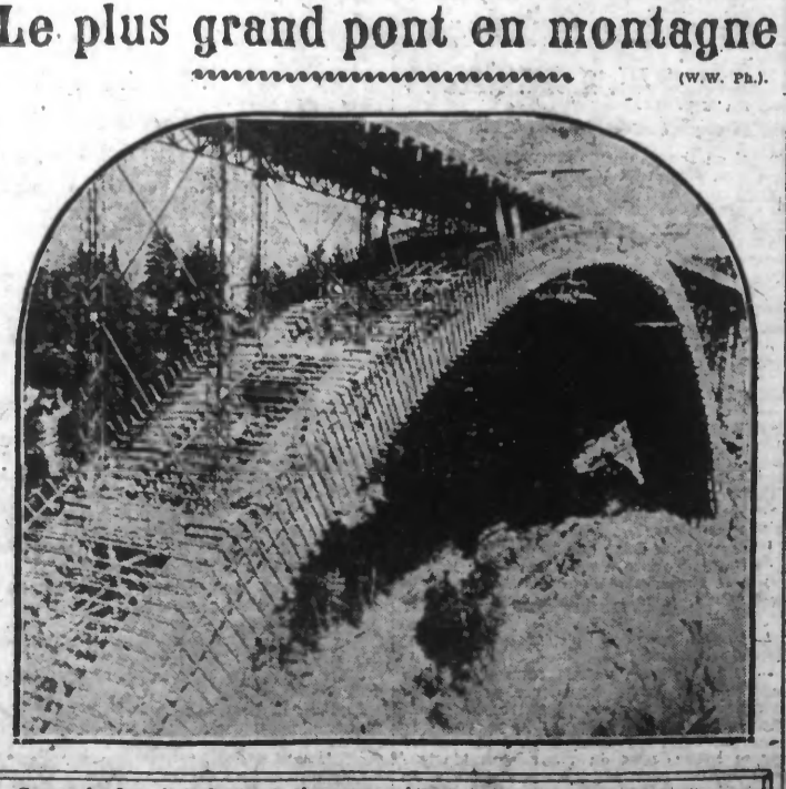
En vue des Jeux de la Fasnol à Oberammergau (Bavière), un pont est en construction au-dessus de l'Abbaye de l'Animer. Il a une longueur de 180 mètres, l'arche 140 mètres. Sa hauteur prise à la rivière sur un est de 70 mètres. Notre photo montre une vue de ce pont qui sera le plus grand d'Allemagne en montagne.
