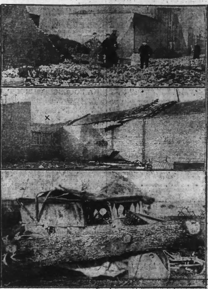
La tempête a fait rage dans notre région et a causé un peu partout des dégâts. Sur notre cliché on voit EN HAUT, la porte d'entrée de la maison Crepel, rue l'Escout, à La Madeleine-les-Lilles, qui a subi de graves dommages. EN BAS, un toit s'est effondré sur un magasin volant, rue des Montagnards, à Lille.
