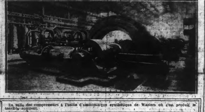
La salle des compresseurs à l'usine d'ammoniaque synthétique de Waziers où s'est produit le terrible accident.
