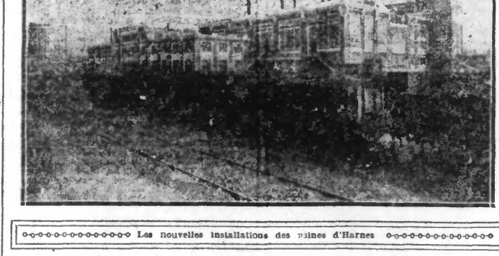
Les nouvelles installations des mines d'Harnes
