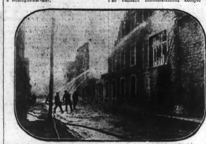
Les pompiers combattant l'incendie
