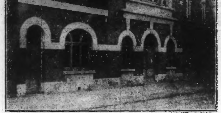
LA FAÇADE DE LA SALLE DES FETES
