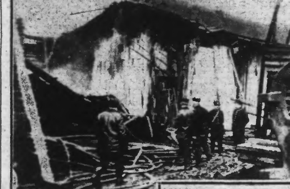
EN HAUT : La partie postérieure du magasin, qui a pu être épargnée. — EN BAS : Un sapeur voyant les débris.
