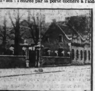
EN HAUT : Le mur de la façade de la propriété VANDERHAEGHEN...
