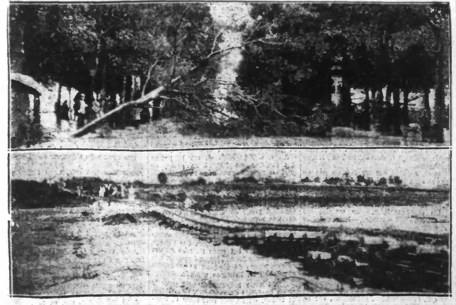
On voit qu'un véritable cataclysme s'est abattu durement sur TUNISIE et la région avoisinante de nombreuses victimes et des dégâts considérables, et isolant la ville de toutes communications avec l'extérieur. « Surtout du côté de BIZERTE où une ligne volante a été installée, permettant la liaison aérienne avec la France. De nombreuses maisons s'élevèrent d'un coup de vent pour supporter un déluge. Il semble que la Tunisie n'ait jamais connu une tempête d'une violence aussi extrême. La situation est particulièrement pénible pour 10.000 naufragés. Nos photos montrent : en haut : Une avenue de TUNISIE ravagée par le cyclone ; en bas : Un aspect de la ville détruite par l'inondation. (W. W. P. R.)
