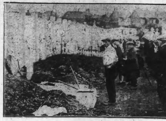
LES TRAVAUX AU CIMETIÈRE DE SAINS-EN-GOHELLE
