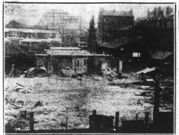
L'emplacement sur lequel seront édifiés prochainement à Lille les nouveaux bâtiments des Instituts de la Houille et du Textile, près de l'Institut de Chimie qu'on aperçoit à droite.
