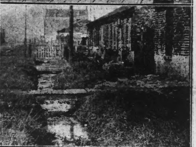
EN HAUT : Deux petits garçons sortant de l'école, marchant sur le trottoir où abondent les poubelles remplies de détritus. EN BAS : Les fossés qui longent les maisons insalubres et où stagnent les eaux sales.
