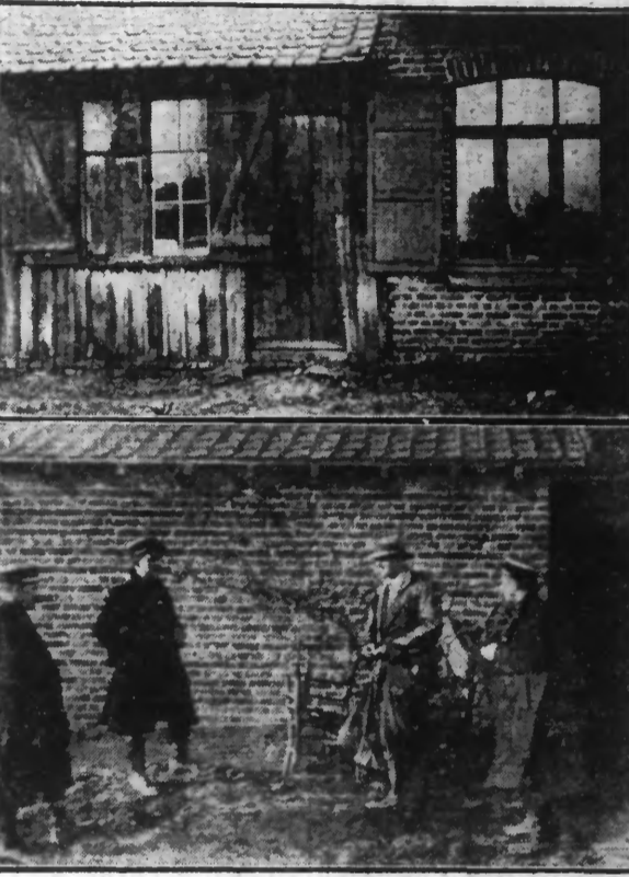
EN HAUT. La maison de la victime, M me Veuve DUBOIS, au hameau de Hamel à BEUVRY; c'est dans la pièce de gauche que fut trouvée la cadavre de l'assassinée. - EN BAS: Les gendarmes de CARVIN et M. DUBOIS, commissaire de Beuvry, enquêtant sur les lieux du crime.
