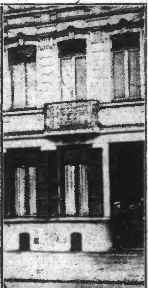
L'immeuble, boulevard Vauban à Lille, où opéra l'audacieux escroc au cautionnement et où sans arrêt, depuis le 3 janvier, quantité de gens viennent tirer la sonnette de la porte.
