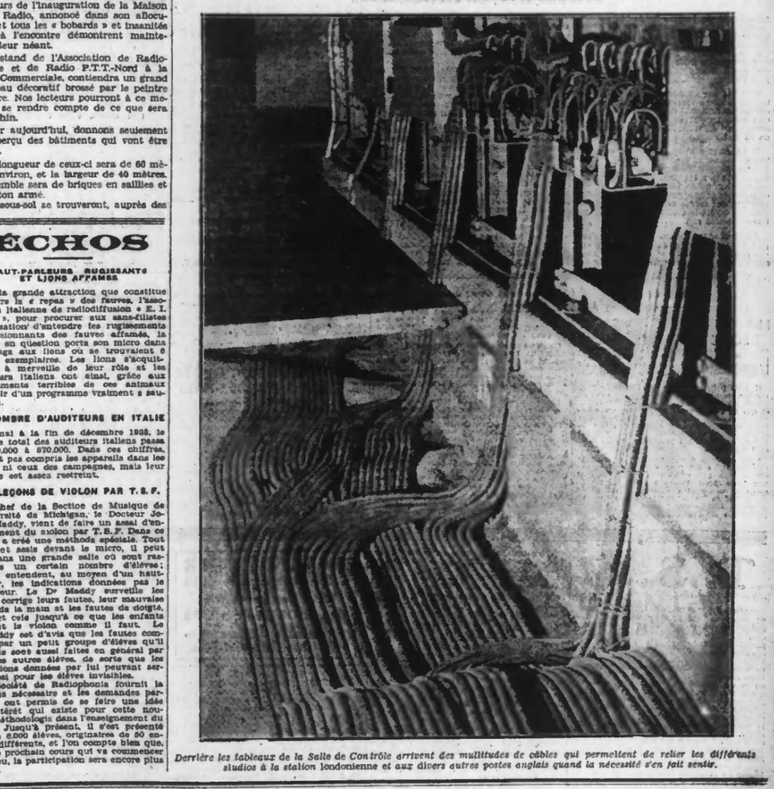
Derrière les tableaux de la Salle de Contrôle arrivent des multitudes de câbles qui permettent de relier les différents studios à la station londonienne et aux divers autres postes anglais quand la nécessité s'en fait sentir.
