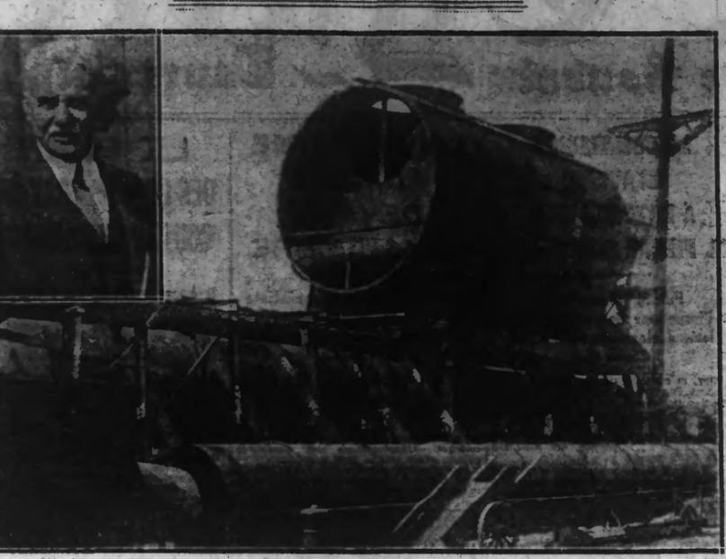
On sait que M. Georges Claude s'emploie à utiliser l'énergie thermique des eaux chaudes de la mer du Nord. Il a installé à Dunkerque un gigantesque tube long de 600 mètres et d'un diamètre de 2 m. 60, constitué par des tronçons de six mètres.
