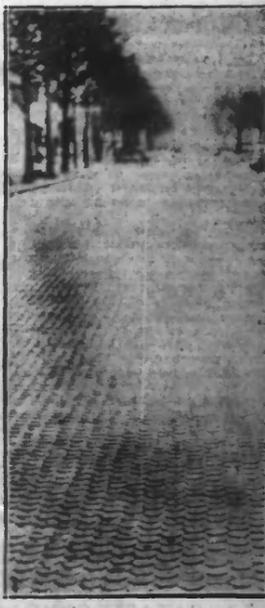
A PARIS, les pavés de bois doivent être supprimés à cause des dérapages par temps de pluie, on les remplace par des pavés métalliques. Notre photo montre une avenue ainsi nouvellement pavée.
