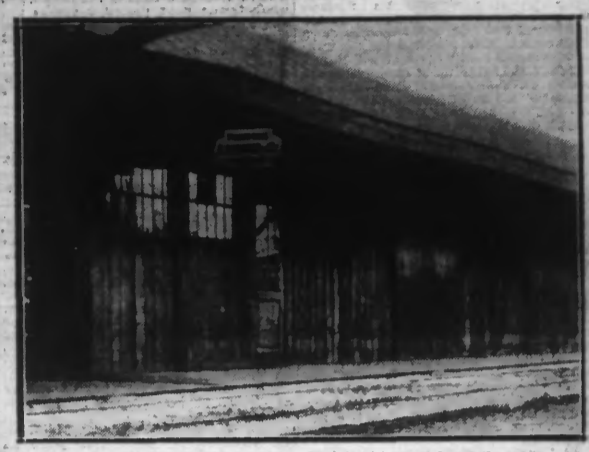
Le bureau de l'Entreprise DERONCQ et Cie à la Grande Vitesse de la Gare de Lille où le vol a été commis.
