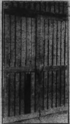
La porte non verrouillée par laquelle sont passés les voleurs.
