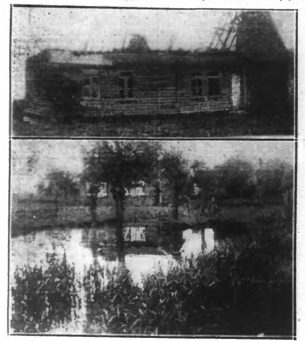
Les ravages causés par les orages successifs dans la région Sud de la Lys et de Laventie. Un barrage qui s'est effondré. — EN BAS : Les champs et une ferme envahis par les eaux.
