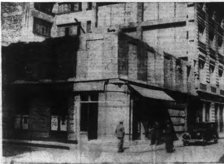
A PARIS, rue Taillout, un immeuble est démolit pour laisser place à un autre plus moderne. Tous les locataires sont partis à temps, sauf un cafetier qui occupe le rez-de-chaussée. Tous les travaux de démolitions ont été effectués sans qu'il ferme son café, dont voici un aspect.
