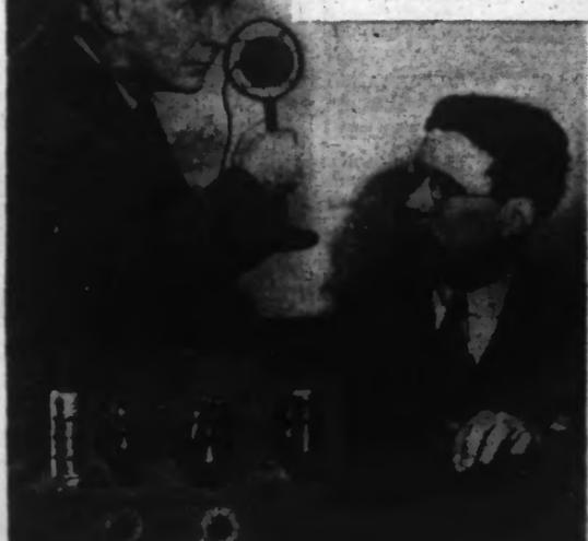
C'est en plaçant les doigts sur un disque de métal qu'un sourd peut recevoir les vibrations de la voix provenant d'ondes amplifiées.
