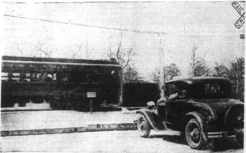
SIGNALISATION EFFICACE. — Une compagnie de chemins de fer américaine a installé, au passage à niveau situé près de la ville de MASSAPEQUA, un appareil de signalisation très efficace. Encastré dans la route, le signal se lève à l'approche d'un train et se baisse quand le convoi est passé. La nuit, les lettres « Stop » sont lumineuses.
