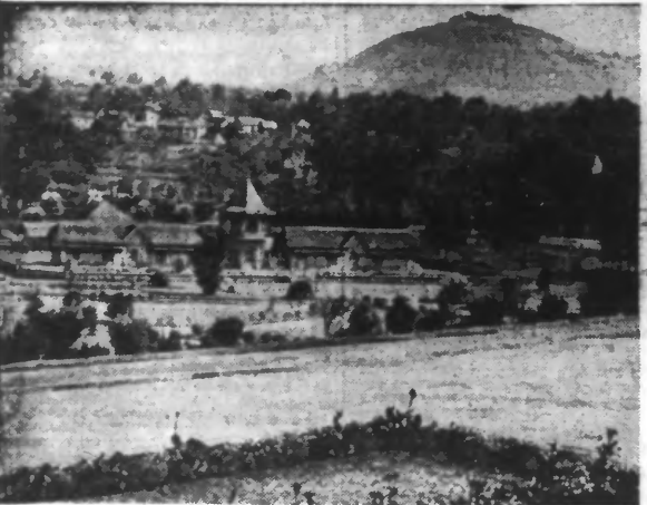
Notre photo montre l'Établissement thermal d'ANTERABE à côté duquel de nouvelles sources viennent de jaillir.
