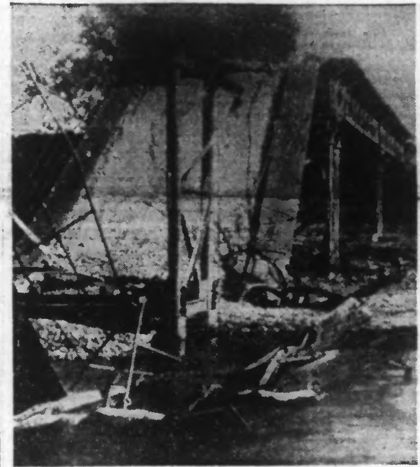
UN PONT SAUTÉ SUR LA ROUTE DE GUADARRAMA
