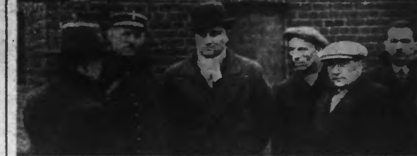
EN HAUT : Le Canal de Saint-Omer à Calais où a été repêché le cadavre, en territoire de COULOGNE, à proximité du « Pont à deux trous ». — EN BAS : M. Félix LERICHE, dont le décès apparaît suspect. — EN BAS : Le fils du défunt, M. Raoul LERICHE, ayant à sa droite M. BRAME, Garde champêtre de la commune et à sa gauche M. Jules DUCROcq, ami intime du noyé, expliquant à notre collaborateur que « son père a été tué ».
