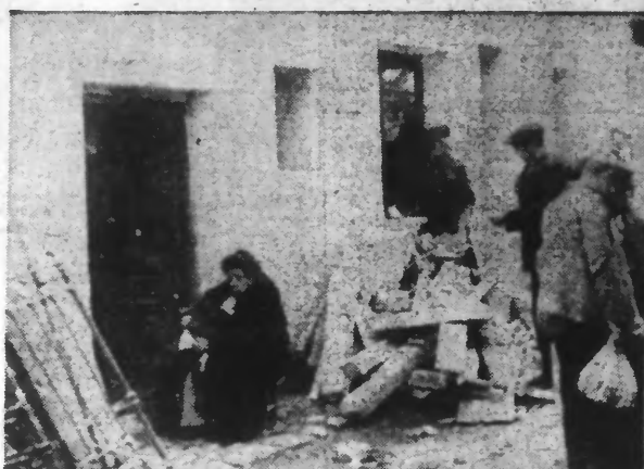
Dans une rue de Madrid, jonchée de meubles brisés, les habitants chassés de leurs maisons détruites.
