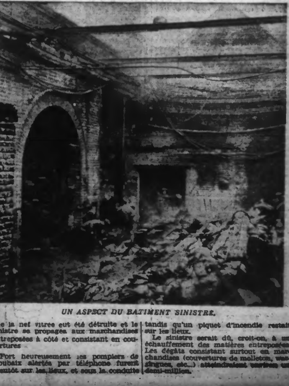
UN ASPECT DU BATIMENT SINISTRÉ. Le sinistre serait dû, croit-on, à un échauffement des matières entreposées. Les dégâts consistent surtout en marchandises (couvertures de maillots, vêtements, etc.) stockées dans un hall d'entrée qui sert à l'emballage. Les secours furent retirés vers 9 h.
