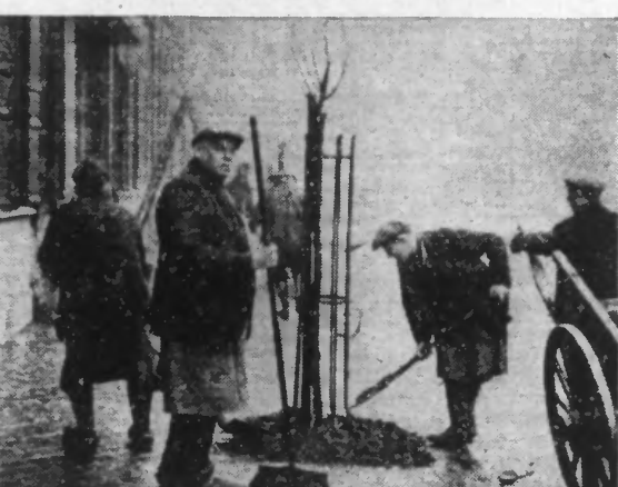
Nous avons dit qu'on profitait des travaux d'aménagement de la rue d'Alsace à ROUBAIX pour planter au long du trottoir de cette artère des arbres. Les services des jardins de Roubaix ont procédé à la mise en place des arbustes qui sont actuellement protégés par un corset de fer et maintenus en place par de solides tuteurs.
