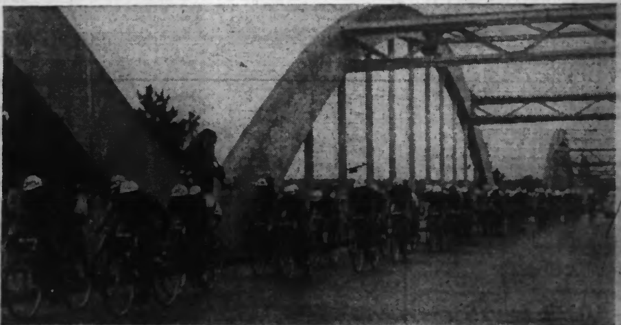
Par sur celui d'AVIGNON, mais sur le pont d'ETRAGNY tout le monde y passe. En effet, aucun coureur n'était réellement lâché à ce moment. (Lire le compte rendu de notre envoyé spécial en « SPORTS »).
