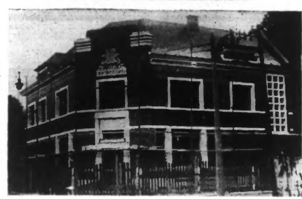
Il y a un peu plus de 18 mois que fut entreprise la construction du nouveau Bureau des Postes du quartier Sainte-Elisabeth, destiné à remplacer celui de la rue Pierre de Roubais. Le gros œuvre du bâtiment est maintenant achevé et les travaux de revêtement seront bientôt terminés.
